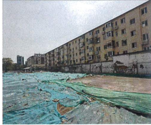
项目南侧围墙情况
