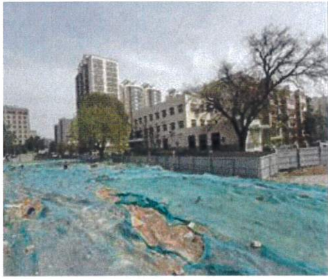
项目东侧围墙情况
